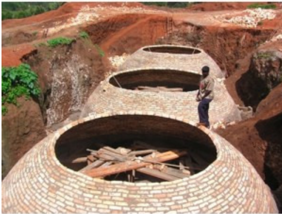
Un impianto a biogas in costruzione
